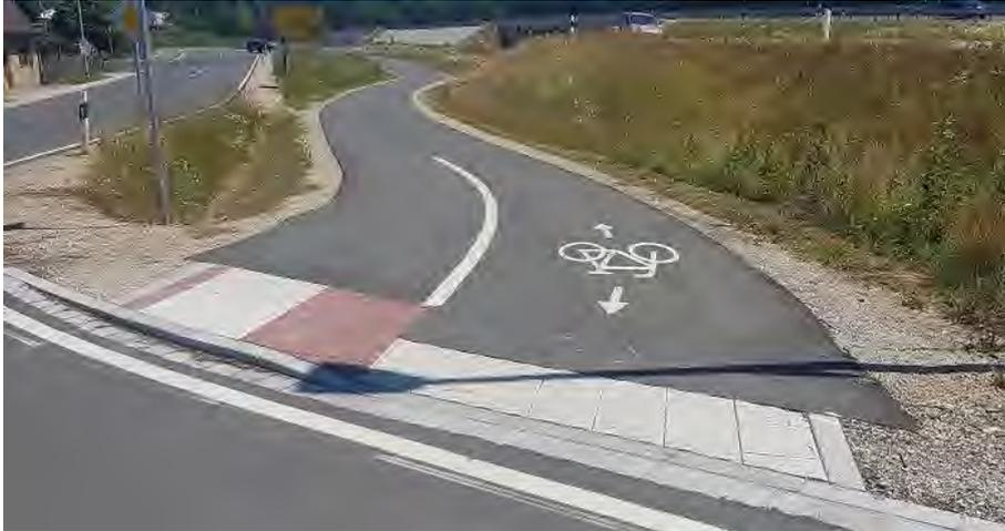
Abbildung 32: Sofern auf eine Materialkante nicht verzichtet werden kann, ist eine Kombination aus Nullabsenkung und Bordkante möglich. Die Absenkung sollte deutlich markiert und der gesamten Breite des kombinierten Geh- und Radwegs entsprechen. Für Blinde und Sehbehinderte sollte der Geh- und Radweg entsprechend aufgeweitet werden (abweichend vom Fotobeispiel).
