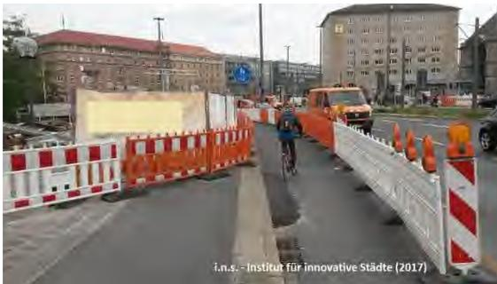
Abbildung 103: Fortsetzung der Radverkehrsführung im Baustellenbereich und Verwendung eines Asphaltkeils zum Überfahren des Hochbords
