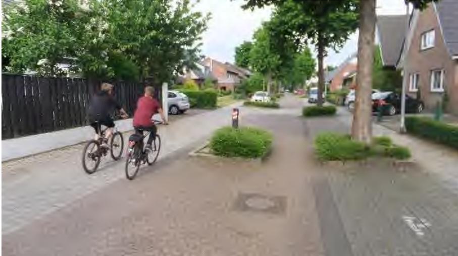
Abbildung 19: Oberflächenstruktur und die Anordnung der begrünten Inseln — u.a. in der Fahrbahnmitte — reduzieren die Geschwindigkeiten in diesem verkehrsberuhigten Bereich (VZ 325) spürbar.
