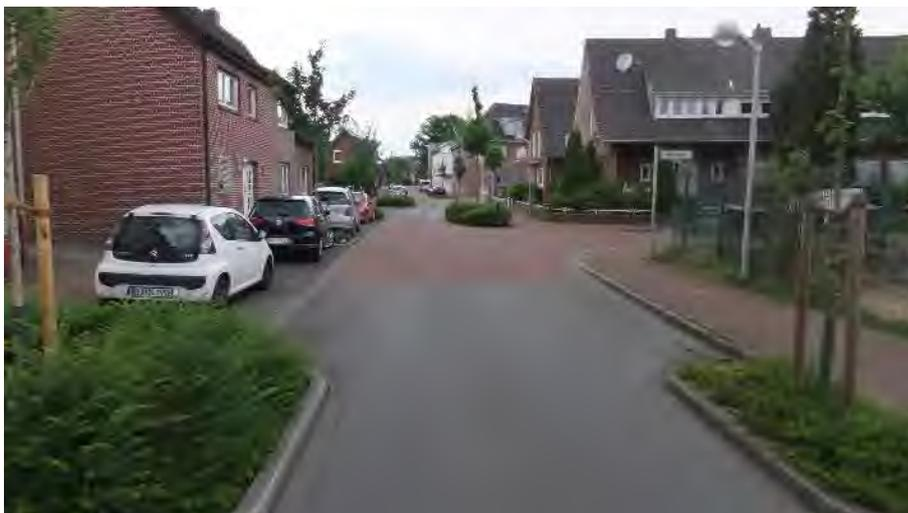
Abbildung 18: Mit Grüninseln werden in dieser Tempo-30-Zone eine Torsituation geschaffen und die Sichtachsen unterbrochen, so dass sich die Geschwindigkeiten reduzieren. Die Parkstände sind baulich ausgebildet und ordnen den Verkehrsraum. Im Einmündungsbereich erfolgt ein Materialwechsel von Asphalt auf Pflastersteine.
