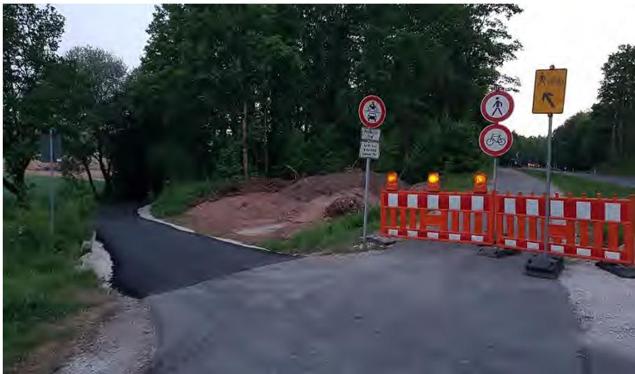
Abbildung 143: Asphaltierung einer Umleitungsstrecke für den Radverkehr
