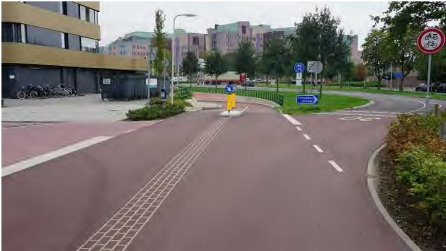
Abbildung 27: Intuitive Wegführung für den Radverkehr durch bauliche Gestaltungsmaßnahmen
