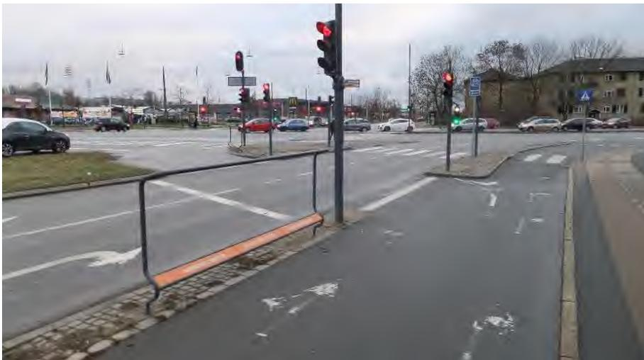
Abbildung 91: Haltestangen mit Fußstütze machen das Warten an Ampeln angenehmer.
