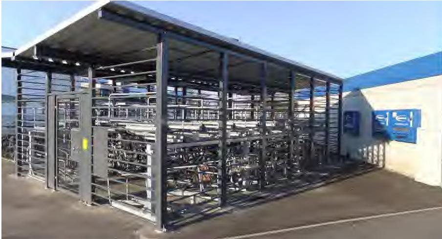
Abbildung 82: Sammelschließanlage mit elektronischer Zugangskontrolle
