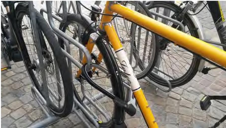
Abbildung 78: Ständer mit Kippschutz, aber zu kurzem AnschlieÙbügel. Der Fahrradrahmen kann mit einem herkömmlichen Schloss nicht angeschlossen werden.
