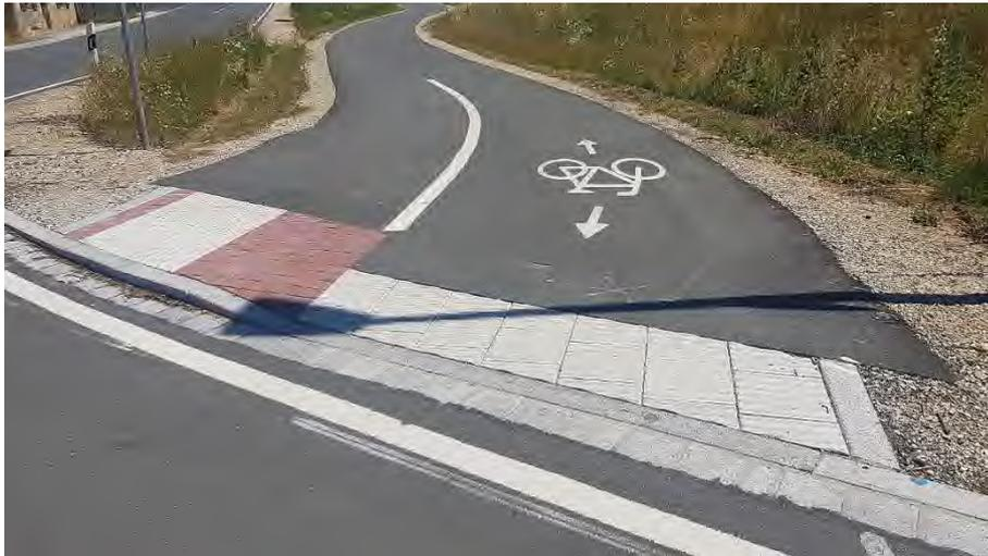
Abbildung 115: Nullabsenkung des Bords für Radfahrer und tastbare Kante für Blinde und Sehbehinderte
