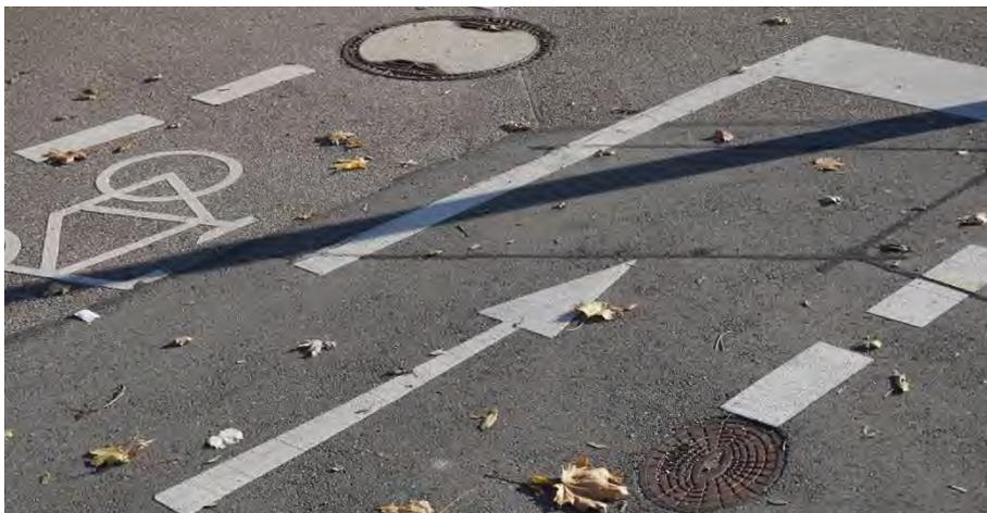
Abbildung 119: Induktionsschleifen auf einem Radweg
