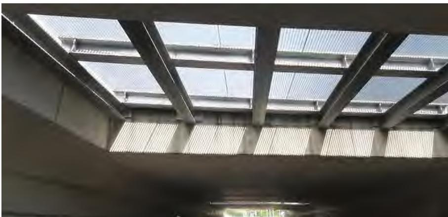
Abbildung 36: Beispiel für die bauliche Ausführung einer natürlichen Beleuchtung in einer Unterführung für den Radverkehr
