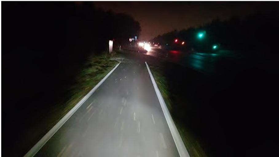
Abbildung 25: Eine weiße Randmarkierung erhöht die Erkennbarkeit der Verkehrsführung gerade bei Dunkelheit erheblich.
