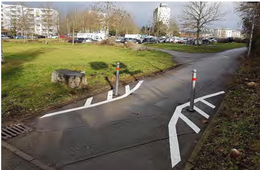
Abbildung 120: Markierung von Pollern auf einem Radweg mit umlaufender Markierung und retroreflektierendem Material
